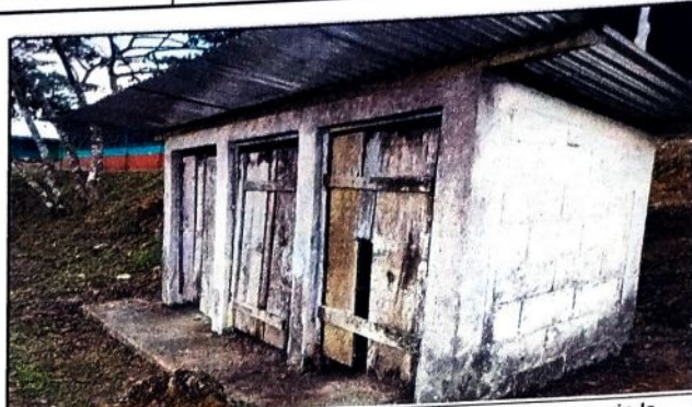
Foto 8: Baños del establecimiento en mal estado y que es necesario la sustitucion de laminas, soporte, puertas y letrinas.
