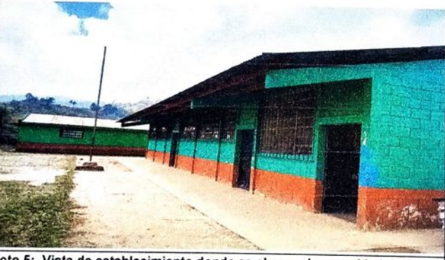
Foto 5: Vista de establecimiento donde se observa la necesidad de colocar canales y bajadas de agua pluvial. Modulo 1
